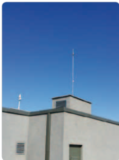
Obr. 1 Aktívny zachytávač na najvyššom bode strechy
