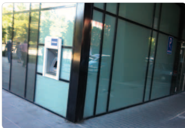
Obr. 4 Neprístupná skúšobná svorka č. 3
