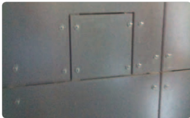
Obr. 3 Neprístupná skúšobná svorka č. 2
