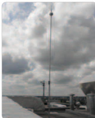
Obr. 5 Aktívny zachytávač na streche druhého objektu
